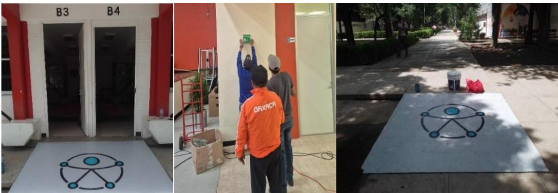
**Imagen No. 15 Pintado de rampas para acceso de personas con discapacidad y colocación de señalización.**
